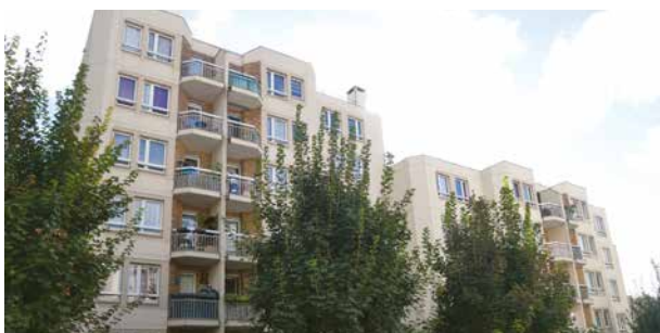
La résidence La Meunerie avant le début du chantier.
